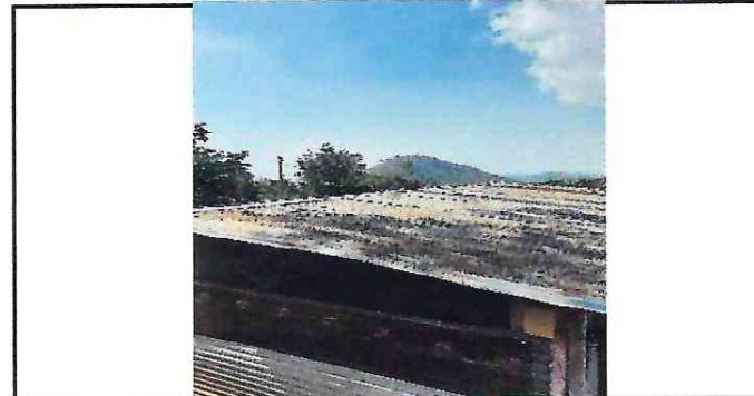
Foto 6: sustitucion de lamina por lamina troquelada
