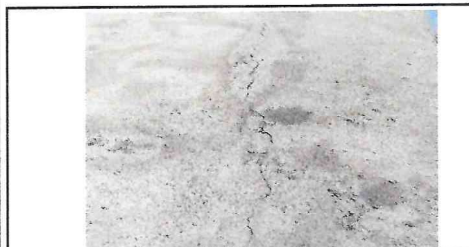
Foto 5: reparacion de piso de torta de concreto
