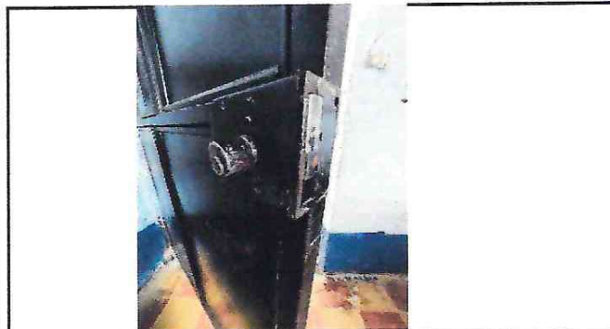
Foto 3: sustitucion de chapa
