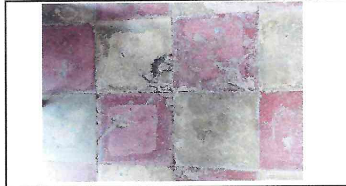
Foto 4: sustitucion de piso de granito
