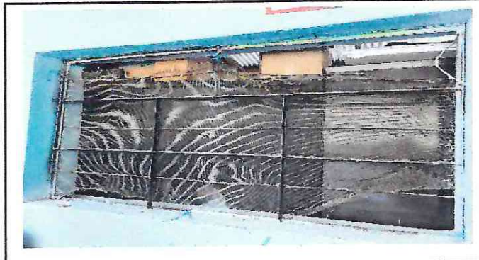
Foto 1: Sustrucion de estructura de metal de ventana
